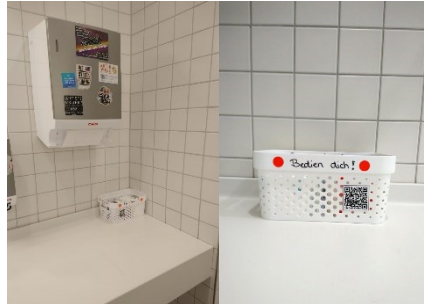
Abb. 1 Hauptgebäude H0100A – Frauentoilette
