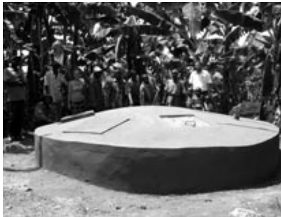
Gemeinsam errichtete Zisterne
